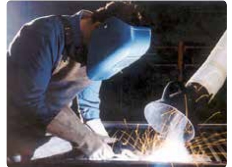
Fest installierte Absauganlage
